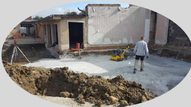
Entkernung und Aufbau der Grundflächen zur Umnutzung einer Werkhalle für den späteren Einbau der 4 Bohle-Bahnenanlage sind im vollen Gange, der störende Pfeiler im späteren Anlaufbereich ist schon weg die Bodenflächen sind vertieft abgesetzt und betoniert, im Moment ist man wie auf dem Foto mit dem späteren Sanitärteil in Arbeit und das Bauschild ist auch schon sichtbar montiert. Es geht also voran an der Baustelle.
